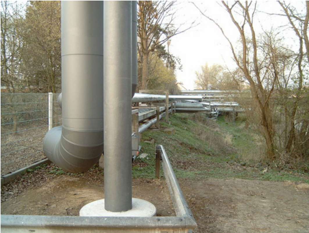
Bild 5: Oberirdische Fernwärmeleitungen.
